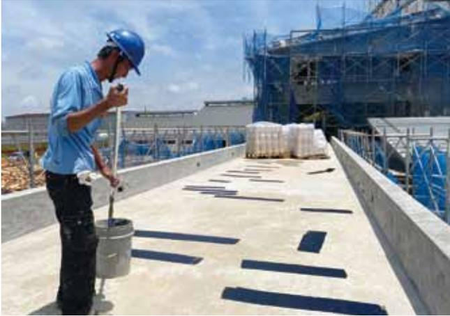
整個園區的防漏塗層必須小心謹慎施工，這攸關日後整體的工程品質。
