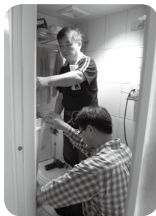
▲治療師與廠商到林老師家協助安裝廁所把手。
